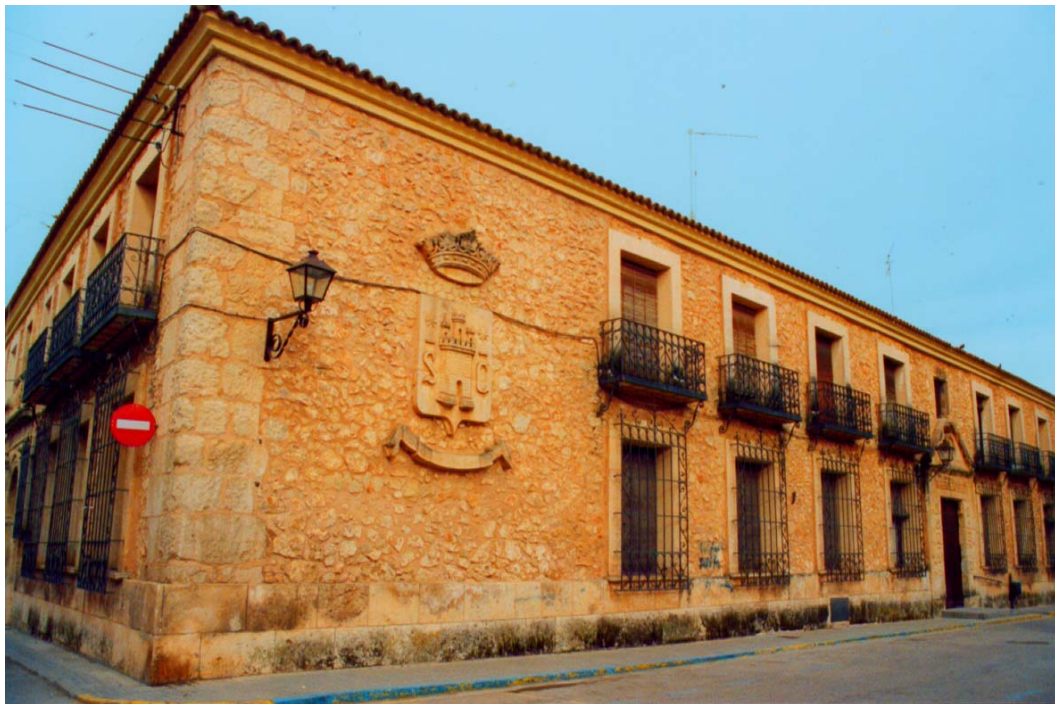
S. Clemente. Arco de cerramiento entre dos plazas (arriba) y casa civil (abajo)
